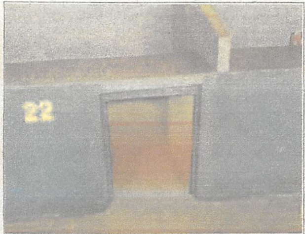
Foto 02- Demolir área da bancada acima do vão de porta.
