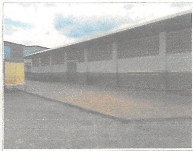
Local para construção de coberta de apoio
