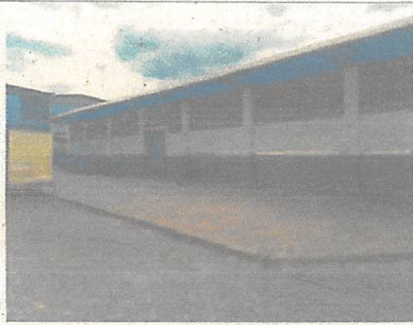
Foto 01- Fachada Sul_ Abertura de vãos para adequação ao layout proposto.
